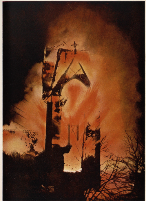
De tyske kommunikaere understreket alltid at tyskerne bare bombet militære mål. Vi ser over alt i landet eksempler på hva de regnet som «militære mål». I Molde gikk den vakre trekirken opp i lys lue etter brann- og sprengbomber som tyskerne kastet i april dagene 1940.
