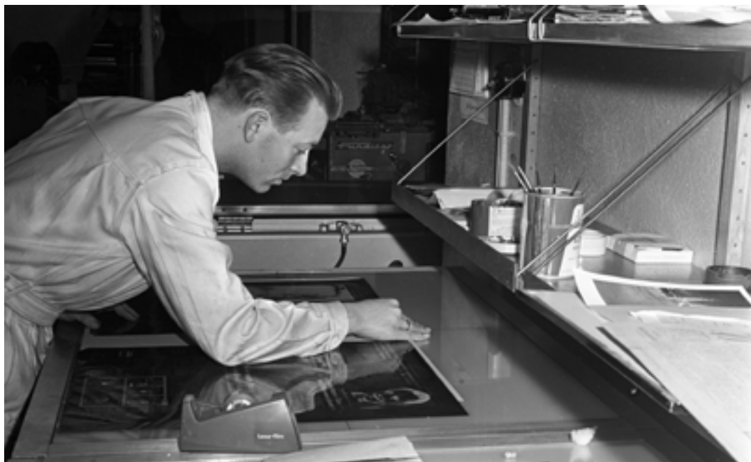
Reprofotograf Sigbjørn Gjersvik i Rana Blad med ferdige filmer som skal kopieres over på offsetplater. (Foto: Arbark)
