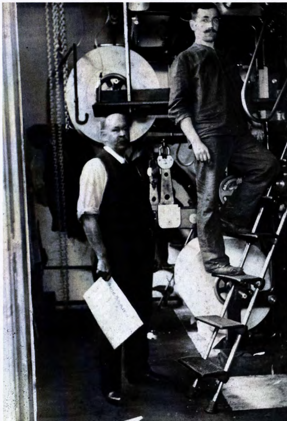
Social-Demokraten satset offensivt i årene før første verdenskrig. I 1912 fikk avisen en 32-siders rotasjonspresse med ekstra stort format. I noen få år framover var dette Norges største trykkpresse. (Foto: Arbeiderbevegelsens arkiv og bibliotek)
