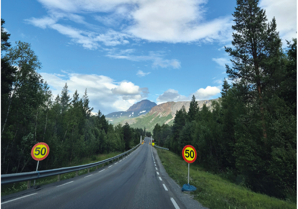
Ikke bare Badderer: Flere steder i vårt langstrakte land går hovedferdselsåren over ei skrøpelig bru. Om den skulle bli stengt, går omkjøringsveien via nabolandet. Disse bruene står der som påminnelser om betydningen av vedlikehold. Her fra Saltdal i Nordland. Foto: Astrid Marie Holand.
